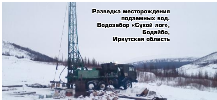
Бурение поисковой скважины на воду
